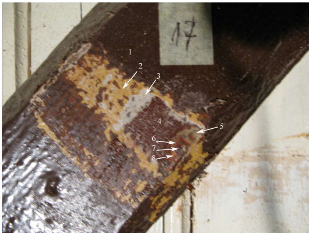
12. Krzyżak balustrady empory od strony zewnętrznej (p.17). Widoczne uwarstwienie: 1. warstwa malarska ciemnobrązowa, 2. warstwa malarska ugrowa, 3. warstwa malarska szarobiała, 4. warstwa malarska brązowa, 5. warstwa malarska szarozielona, 6. warstwa malarska siena naturalna, 7. warstwa malarska siena palona (oryginalna), 8. drewno.
