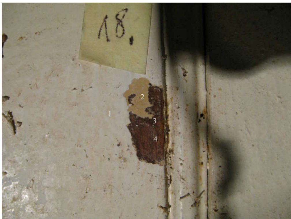
13. Płytyca (deskowanie) balustrady empery od strony zewnętrznej (p.18). Widoczne uwarstwienie: 1. warstwa malarska beżowobiała, 2. warstwa malarska różowobeżowa, 3. warstwa malarska siena naturalna, 4. warstwa malarska siena palona (oryginalna).
