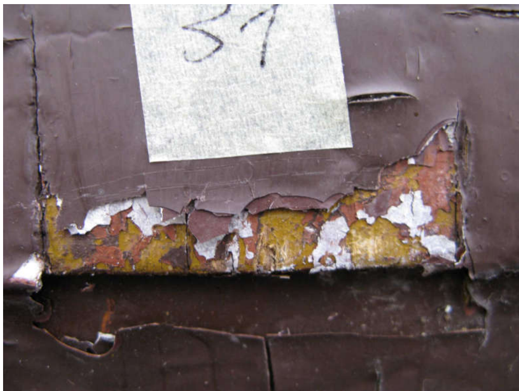
16. Płycina drzwi głównych od strony zewnętrznej. Widoczne nawarstwienia zachowane fragmentarycznie. Brak ciągłości warstw. Widoczne wtórne wymalowania po ubytkach.
