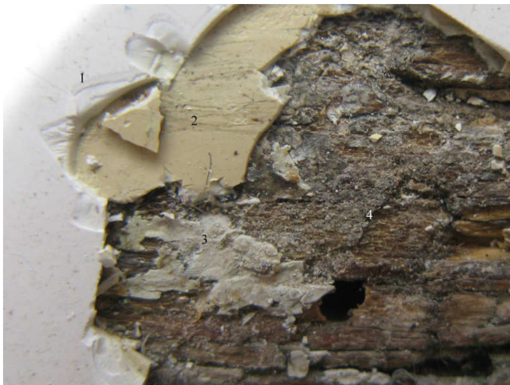
14. Parapet okna od wewnątrz (od strony elewacji południowo-wschodniej – p. 20). Widoczne uwarstwienia: 1. warstwa malarska biała, 2. warstwa malarska biała beżowawa, 3. warstwa malarska biała (oryginalna), 4. drewno.
