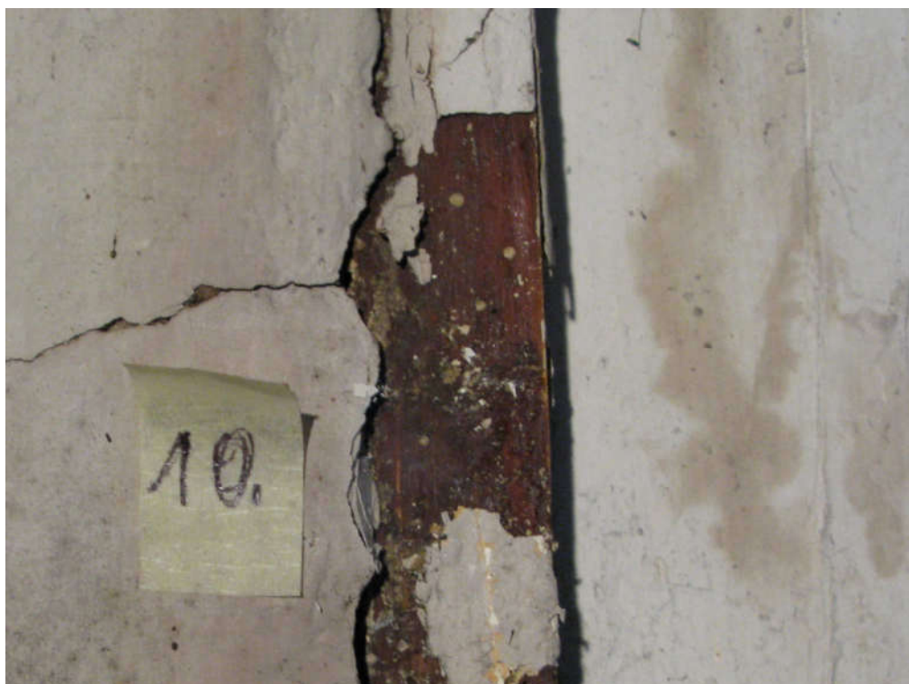
5. Rama stolcowa (słupek) p. 10.– w odkrywce widoczna oryginal warstwa malarska.
