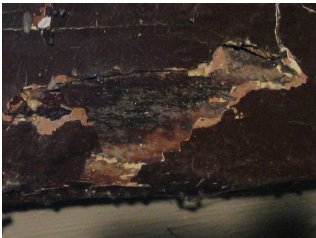
6. Rama stolcowa (belka) p. 9. – w odkrywce widoczna oryginal warstwa malarska.
